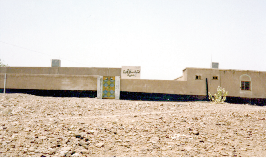
صورة رقم ١١): مبنى المحكمة الشرعية بقريّة المسافيّة، إمارة الفجيرة، صيف ١٩٨٧م، المصدر: (©Yateem Archive)
